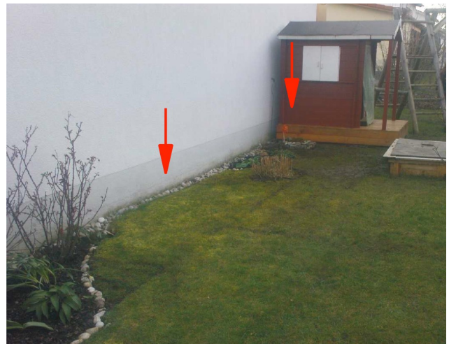
Garten unmittelbar an der Garagenwand nach Beendigung der Gründungssanierung.
